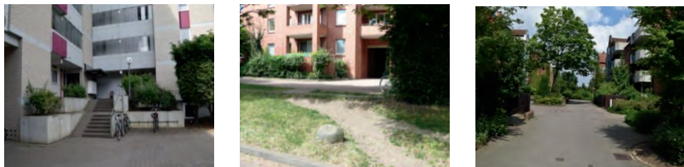
Fotos: klare Wegführung aber schlecht erkennbare Unterführungen, fehlende Hausnummern (Fotos: LKA)
